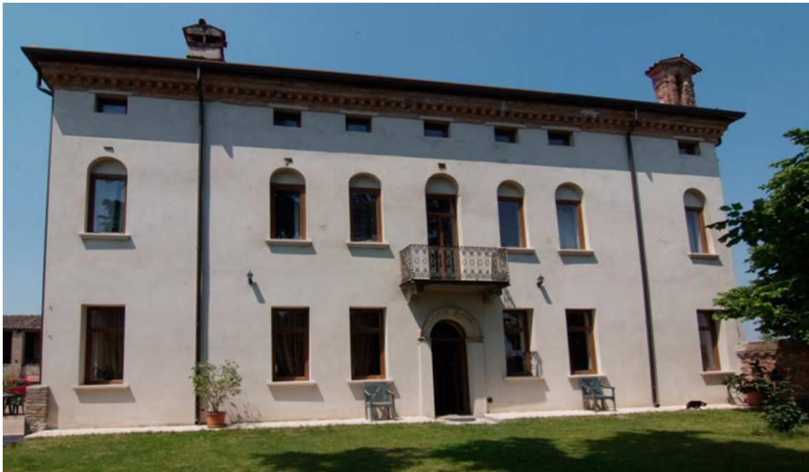
Villa Pisani, ad Albaredo d'Adige (Vr). L'edificio seicentesco come si presenta oggi, dopo i recenti lavori di restauro.
